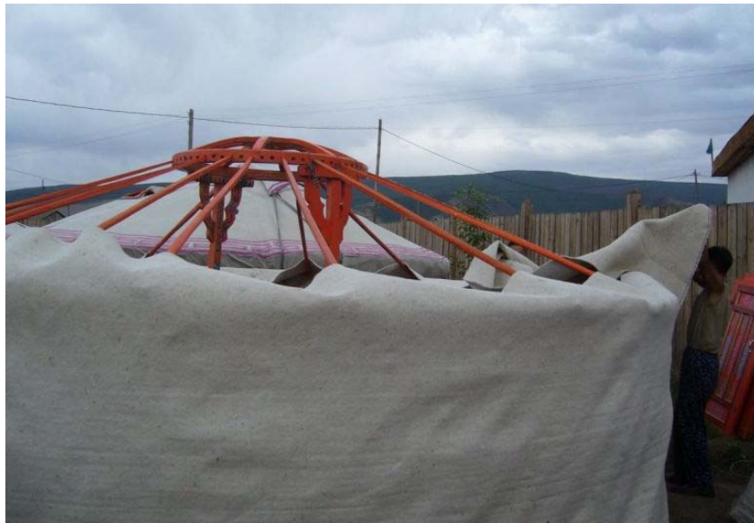
Abbildung 6: Filzummantelung der Jurte (Foto: H.-G. UNTERRAINER).
